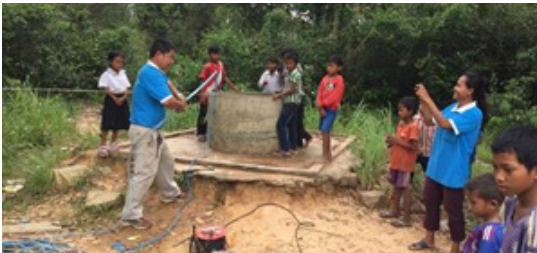
식수 펌프 테스트 1
