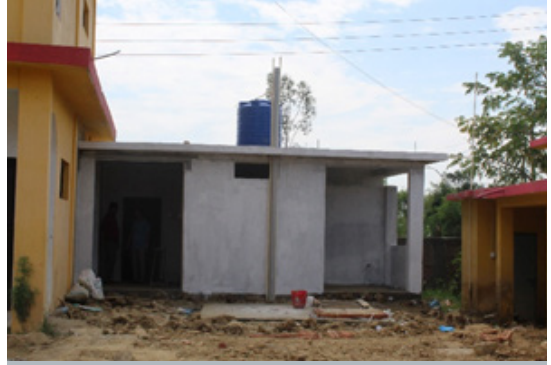
성별이 구분된 화장실 건설 작업 진행 상황
