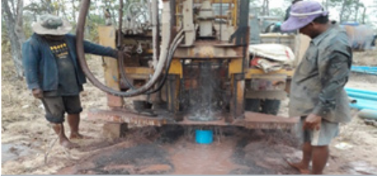
식수 시설 설치를 위한 플랫폼 공사 1
