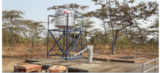
식수 시설 설치를 위한 플랫폼 공사 2
