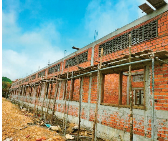
△ 교실 건축 - 내/외벽 공사
