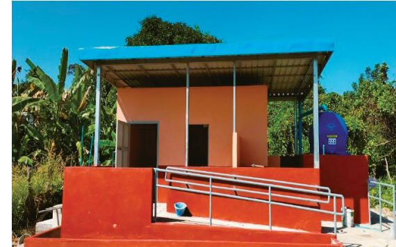
△ 완공된 신축 화장실
