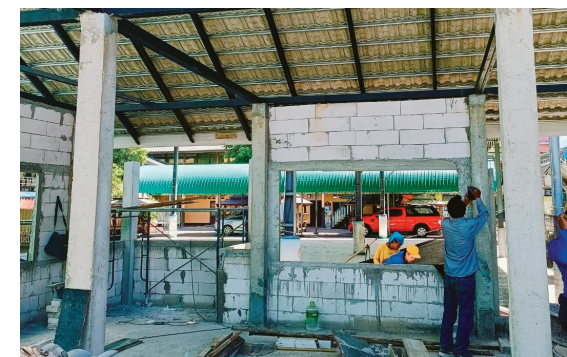
△ 도서관 건축 공사 (2) - 지붕 타일 작업
