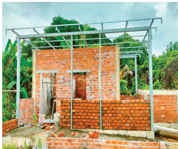
△ 화장실 건축 - 벽돌 조적 공사
