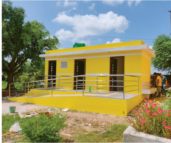
△ 교내 남녀 구분된 화장실 건축
