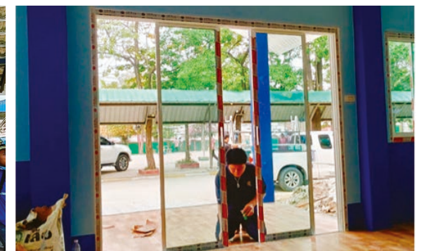
△ 도서관 건축 공사 (3) - 출입문 설치
