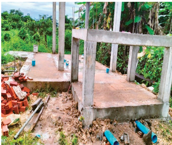
△ 화장실 건축 - 배관 공사
