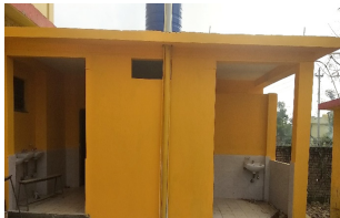
| 개보수 완료된 남/여가 구분된 화장실
